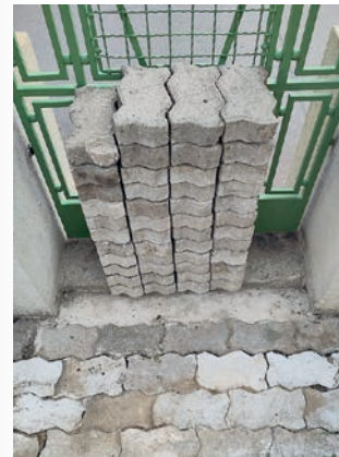
Kompostierbare Pflastersteine zum Entsiegeln der Straße: vorher ...
